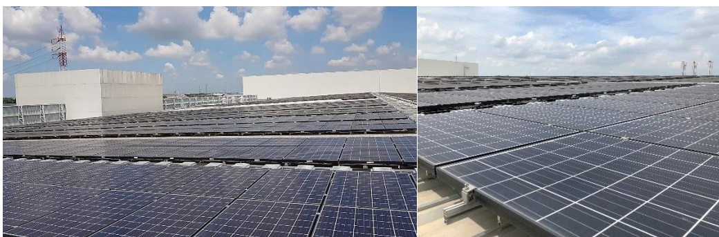
รูปที่ 1 ภาพแสดงบริเวณที่ดำเนินการติดตั้งแผงติดตั้งแผงเซลล์แสงอาทิตย์
