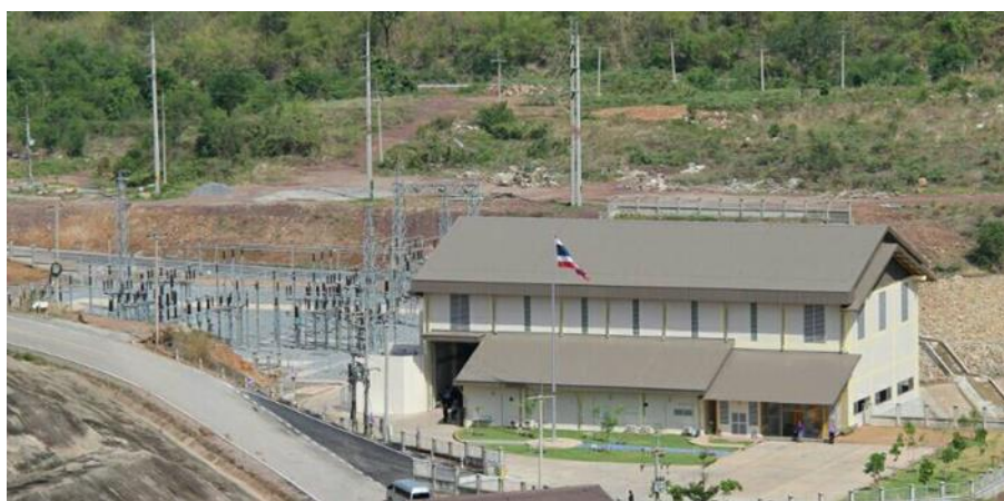
รูปที่ 1 โรงไฟฟ้าพลังน้ำเขื่อนแควน้อยบำรุงแดน
