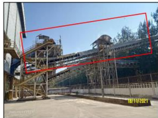
รูปที่ 2-4 สายพานลำเลียงกากอ้อยเป็นระบบปิด
