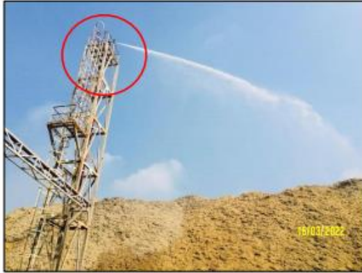
รูปที่ 2-11 การฉีดพรมน้ำบริเวณกองเก็บเชื้อเพลิง (กากอ้อย) เพื่อลดปัญหาฝุ่นละออง
