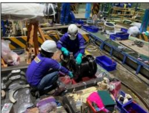
รูปที่ 2-47 ตรวจสอบสภาพการใช้งานและซ่อมบำรุง (3)
