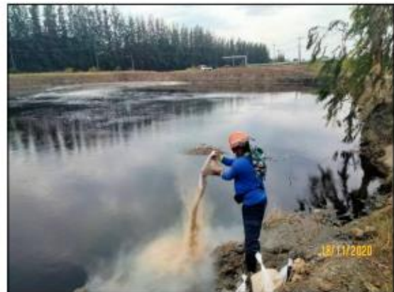
รูปที่ 2-10 เติมเชื้อจุลินทรีย์ EM ในบ่อบำบัดน้ำเสียเพื่อปรับสภาพของน้ำเสีย
