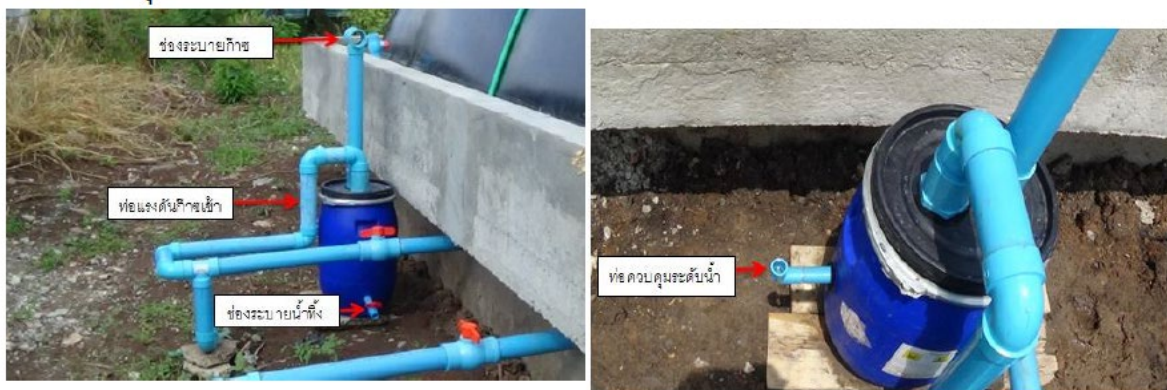
รูปที่ 6 ภาพแสดงชุดอุปกรณ์ควบคุมแรงดันบ่อหมักก๊าซชีวภาพ
