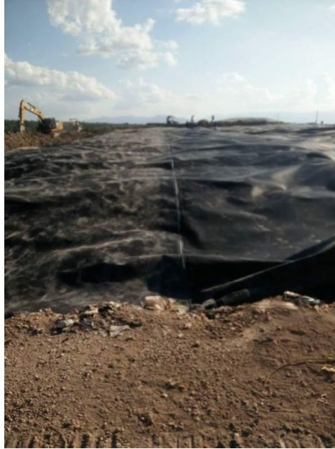
รูปที่ 13 การนำแผ่น HDPE มาคลุมผิวหน้าบ่อขยะมูลฝอยเพื่อเก็บรวบรวมแก๊ส
