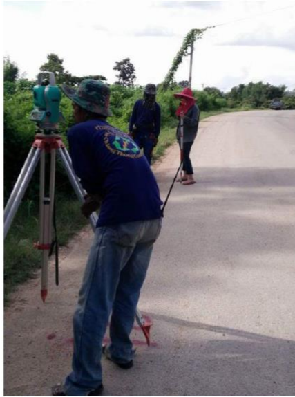
รูปที่ 1 การสำรวจแนววางท่อแก๊ส ส่งแก๊สไปใช้ในบ้านแม่ยูน (1)
