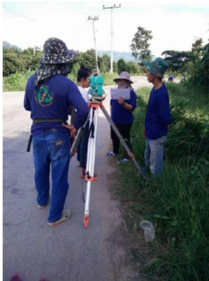
รูปที่ 2 การสำรวจแนววางท่อแก๊ส ส่งแก๊สไปใช้ในบ้านแม่ยูน (2)
