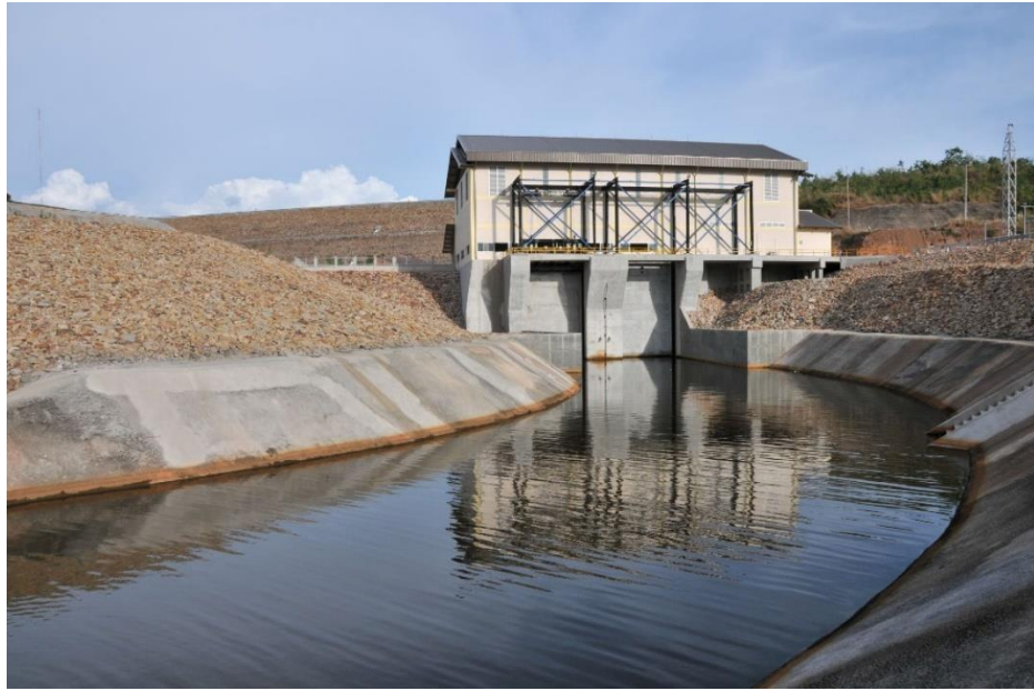
รูปที่ 1 โรงไฟฟ้าเขื่อนแควน้อยบำรุงแดน
