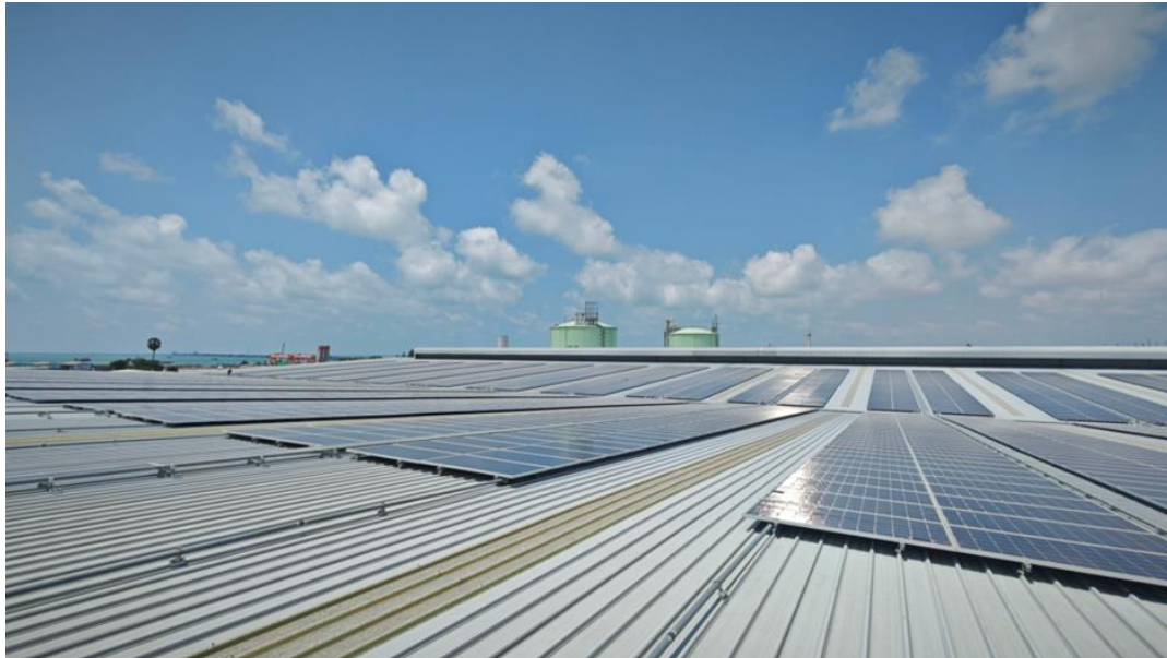
รูปที่2 ภาพแสดงสภาพโครงการปัจจุบัน
