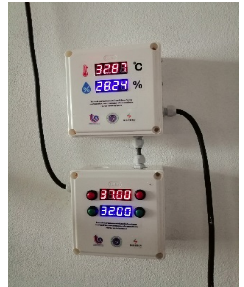
เซนเซอร์วัดอุณหภูมิ ความชื้น และควบคุมการเปิด-ปิดพัดลมระบายอากาศ
