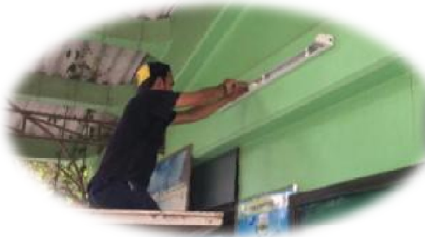
เปลี่ยนหลอดไฟลูออเรสเซนต์เป็นหลอด LED
