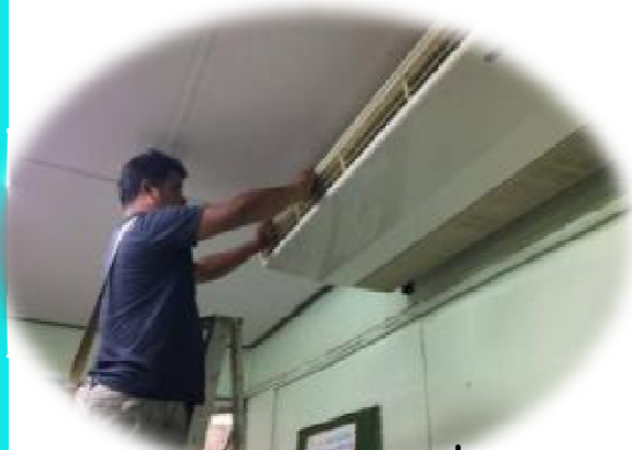
ซ่อมแซมและดูแลอุปกรณ์เครื่องใช้ไฟฟ้า
