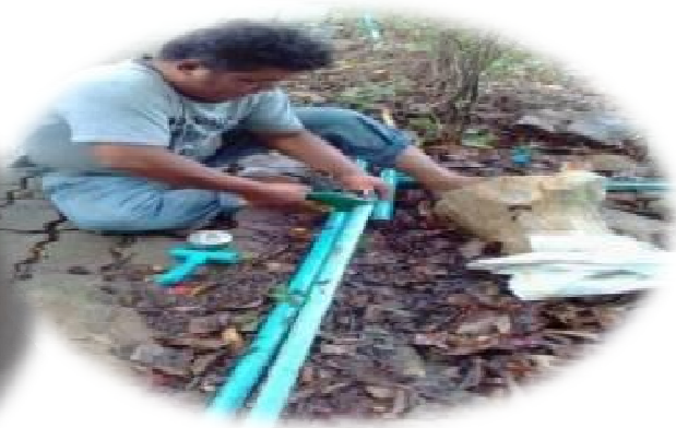
ซ่อมแซมท่อประปา ก๊อกน้ำ
