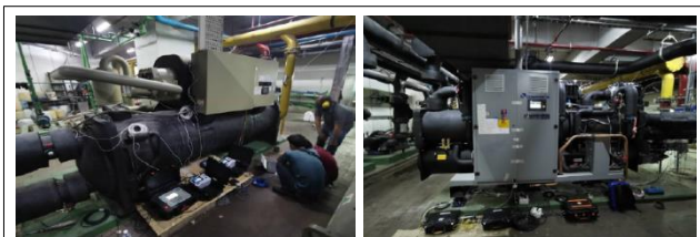
ติดตั้งเครื่องทำน้ำเย็น Magnetic Oil Free Chiller ขนาด 400 TR
