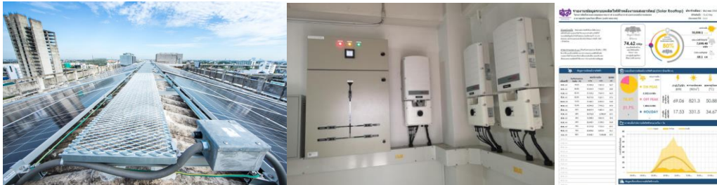
ภาพการดำเนินกิจกรรม การติดตั้งแผงโซลาร์เซลล์แสงอาทิตย์บนหลังคาเพื่อผลิตไฟฟ้า
