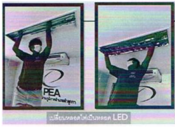
เปลี่ยนหลอดไฟเป็นหลอด LED
