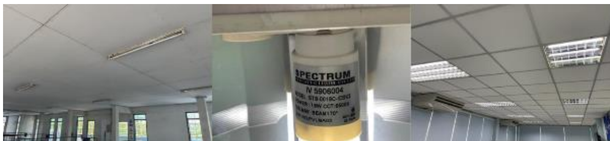
เปลี่ยนหลอด Fluorescent ขนาด 36W เป็นหลอด LED T8 ขนาด 18W
