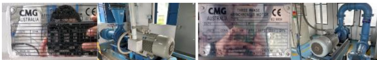
ปรับเปลี่ยนมอเตอร์ทั่วไปเป็นมอเตอร์ประสิทธิภาพสูง
