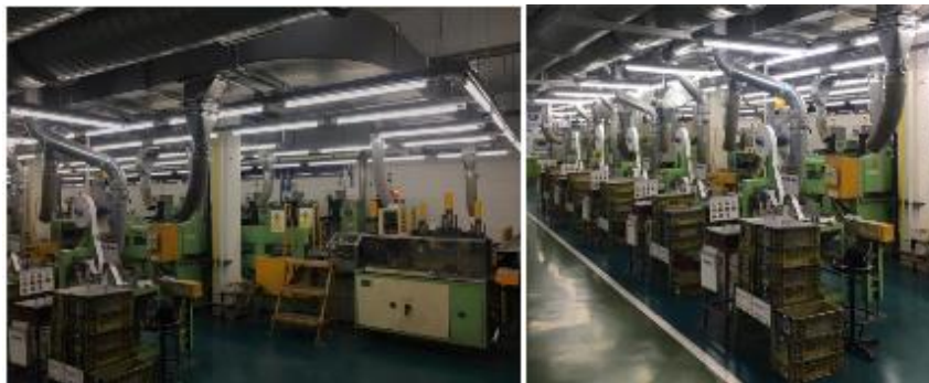
การเปลี่ยนหลอดไฟฟ้าจากหลอด Fluorescent เป็นหลอด LED
