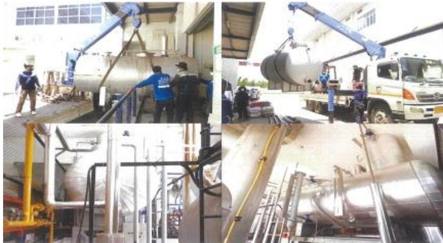
การติดตั้ง Deaerator
