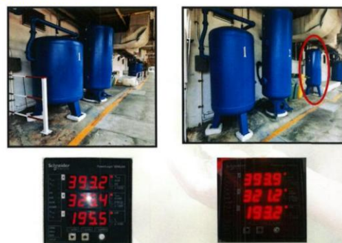
1.2 มาตรการติดตั้งถังเก็บลม
