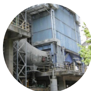
ข) Waste Heat Recovery Unit ในโรงงานผลิตปูนซีเมนต์
