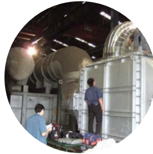
ข) การนำความร้อนทิ้งมาถ่ายเทความร้อนให้แก่อากาศที่เข้าเตา
