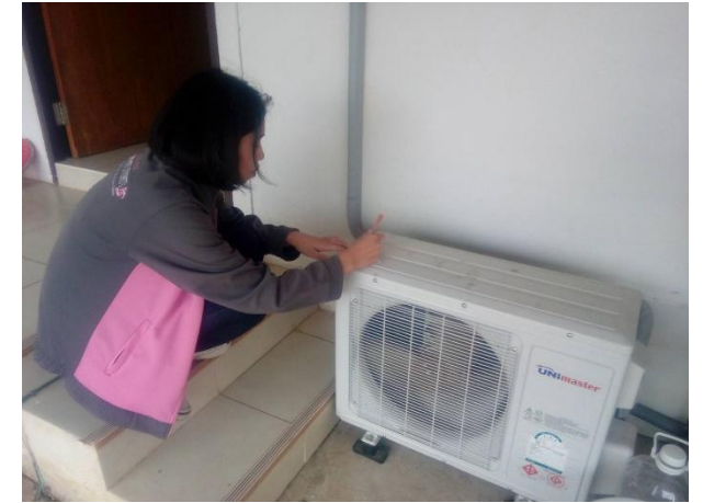
การติดตั้งเครื่องปรับอากาศประสิทธิภาพสูงเพื่อทดแทน
