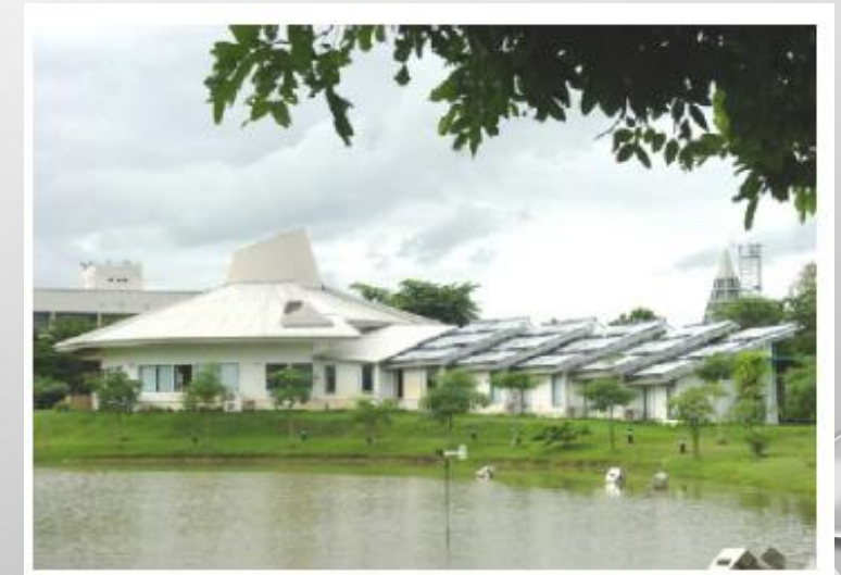
Site Ref. : การติดตั้งระบบผลิตน้ำร้อนจากหลอดสุญญากาศ
