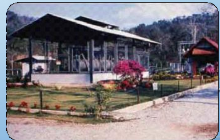
โรงไฟฟ้า ORC อ.ฝาง จ.เชียงใหม่
