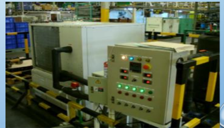
ปั๊มความร้อนขนาด 45 kW ความร้อน ใช้ทำความร้อนทดแทนการใช้ ใช้น้ำในการทำความร้อน
