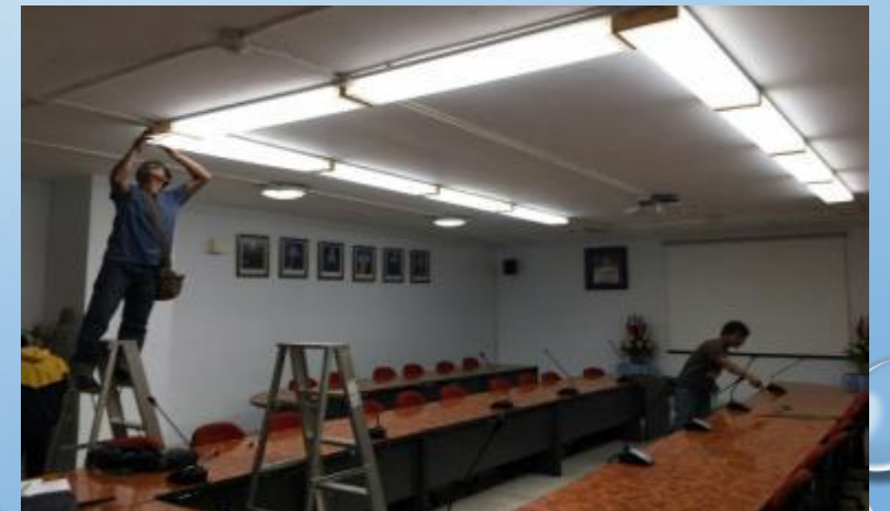
การเปลี่ยนหลอด LED ในอาคารสำนักงาน
