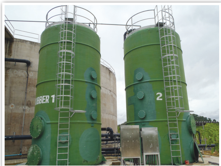
รูปที่ 4.12 อุปกรณ์กำจัด ก๊าซไฮโดรเจนซัลไฟด์ ( H_2S ) ในก๊าซชีวภาพ
