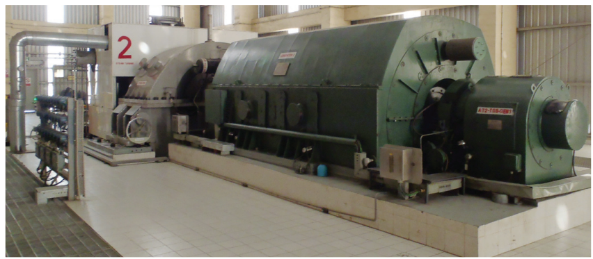
รูปที่ 4.31 อุปกรณ์หลักในโครงการกลไกการพัฒนาที่สะอาดประเภทผลิตไฟฟ้า จากลมร้อนทิ้งของโรงงานผลิตปูนซีเมนต์ (Boiler Generator และ ระบบกำจัดฝุ่น)
