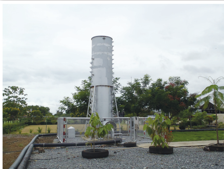
รูปที่ 4.17 ปล่องเผาก๊าซทิ้ง (Flare)
