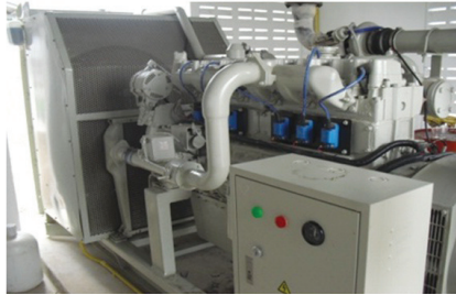
รูปที่ 4.10 ตัวอย่างโครงการกลไกการพัฒนาที่สะอาดประเภทผลิตไฟฟ้าจากก๊าซชีวภาพจากน้ำเสียของฟาร์มสุกร
