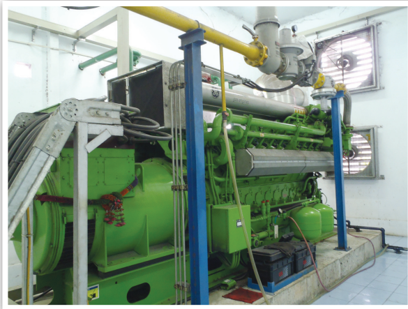
รูปที่ 4.16 เครื่องยนต์ผลิตไฟฟ้า (Gas Engine)
