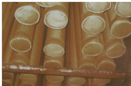
รูปที่ 4.23 ระบบบำบัดฝุ่นแบบผ้ากรอง (Bag Filter หรือ Bag House)
