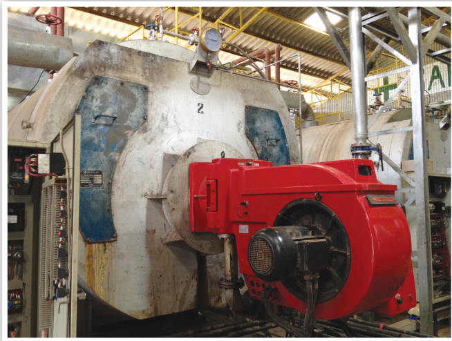
รูปที่ 4.15 หม้อต้มไอน้ำ (Hot Oil Boiler) และ หัวเผา (Burner )
