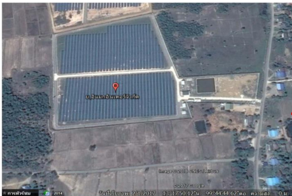
โครงการผลิตไฟฟ้าพลังงานแสงอาทิตย์ของบริษัท อีแมกอินเตอร์ จำกัด จังหวัดเพชรบุรี ขนาดการติดตั้ง 4.4 เมกะวัตต์พีค
