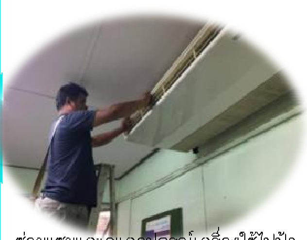
เปลี่ยนหลอดไฟลูออเรสเซนต์เป็นหลอด LED
