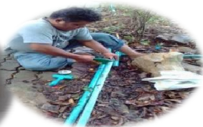
ซ่อมแซมท่อประปา รั่วกน้ำ
