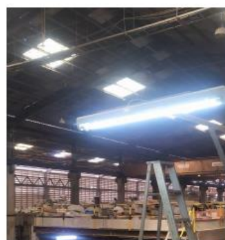
หลังเปลี่ยนหลอดไฟ
