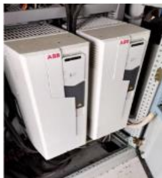
การติดตั้ง inverter ควบคุมความถี่ (Hz) เพื่อลดกระแสมอเตอร์
