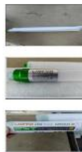
เปลี่ยนชุดหลอดไฟแสงสว่างจากหลอดฟลูออเรสเซนต์ที่ใช้บัลลาสต์เป็น LED T8
