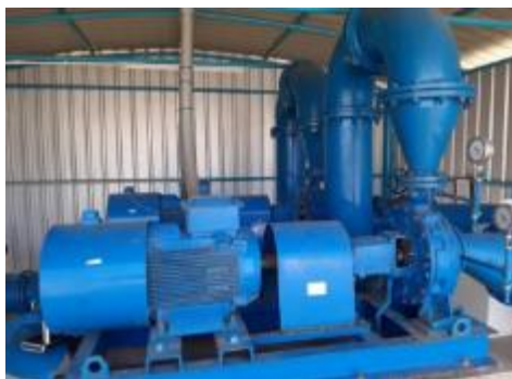
การติดตั้ง inverter ควบคุมความถี่ (Hz) เพื่อลดกระแสมอเตอร์
