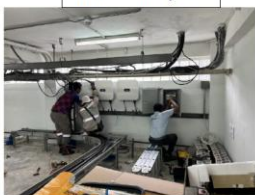
ขณะดำเนินการติดตั้งอุปกรณ์
