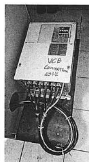
ติดตั้ง INVERTOR
