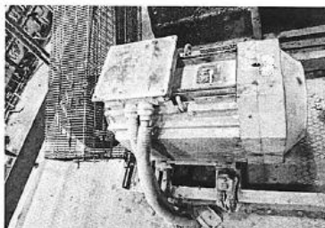
MOTOR เดิม 22 KW 1400 RPM
