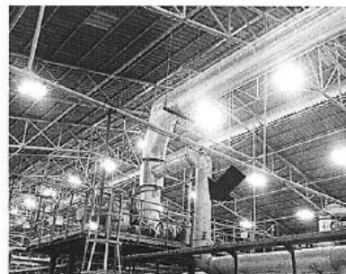
ติดตั้งท่อใหม่เข้าพัดลม COMBUSTION โดยตรงแทนพัดลม HEAT SUCTION
