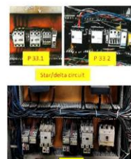
ภาพประกอบ วัสดุ Star/delta ที่ Circulation pump(P33) and Ventilation Fan(V35) of HCl Wet Scrubber
