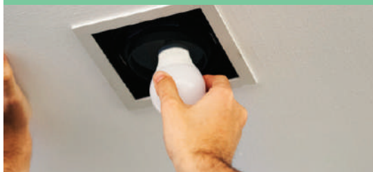
การเปลี่ยนหลอดไฟเป็นแบบ LED
