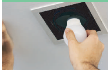
การเปลี่ยนหลอดไฟเป็นแบบ LED
