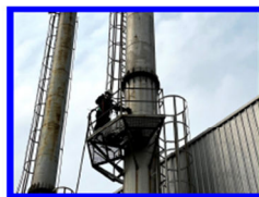
พื้นที่ตรวจวัด : โรงงาน 1 / BOILER No.1 (15 Ton)
