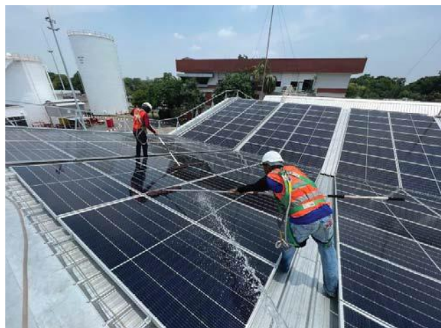
รูปภาพที่ 18-19 แสดงภาพการตรวจสอบอุปกรณ์ การจัดบันทึกข้อมูล และการทำความสะอาดแผงโซลาร์เซลล์ตามแผนการดำเนินงานปีละ 2 ครั้ง พื้นที่บริษัท บริการเชื้อเพลิงการบินกรุงเทพมหานคร จำกัด (มหาชน)
