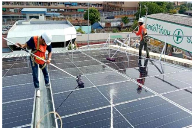
รูปภาพที่ 21-22 แสดงภาพการตรวจสอบอุปกรณ์ การจัดบันทึกข้อมูล และการทำความสะอาดแผงโซลาร์เซลล์ตามแผนการดำเนินงานปีละ 2 ครั้ง พื้นที่บริษัท บาฟส์ขนส่งทางท่อ จำกัด (สำนักงานใหญ่)
