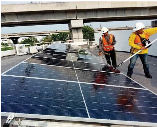
รูปภาพที่ 21-22 แสดงภาพการตรวจสอบอุปกรณ์ การจัดบันทึกข้อมูล และการทำความสะอาดแผงโซลาร์เซลล์ตามแผนการดำเนินงานปีละ 2 ครั้ง พื้นที่บริษัท บาฟส์ขนส่งทางท่อ จำกัด (สำนักงานใหญ่)
