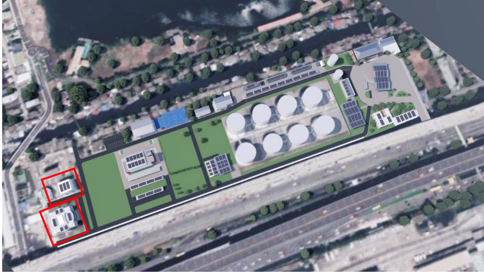
พิกัดโครงการพื้นที่ บริษัท ขนส่งน้ำมันทางท่อ จำกัด (สำนักงานใหญ่) 13.901940778777897, 100.59020216449152
