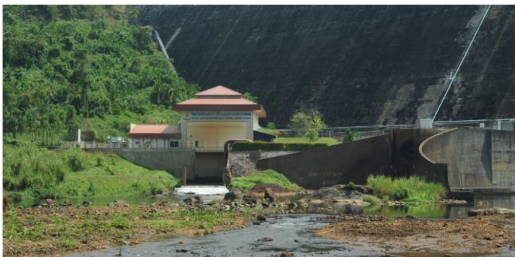
รูปที่ 1 โครงการโรงไฟฟ้าพลังน้ำเขื่อนขุนด่านปราการชล
