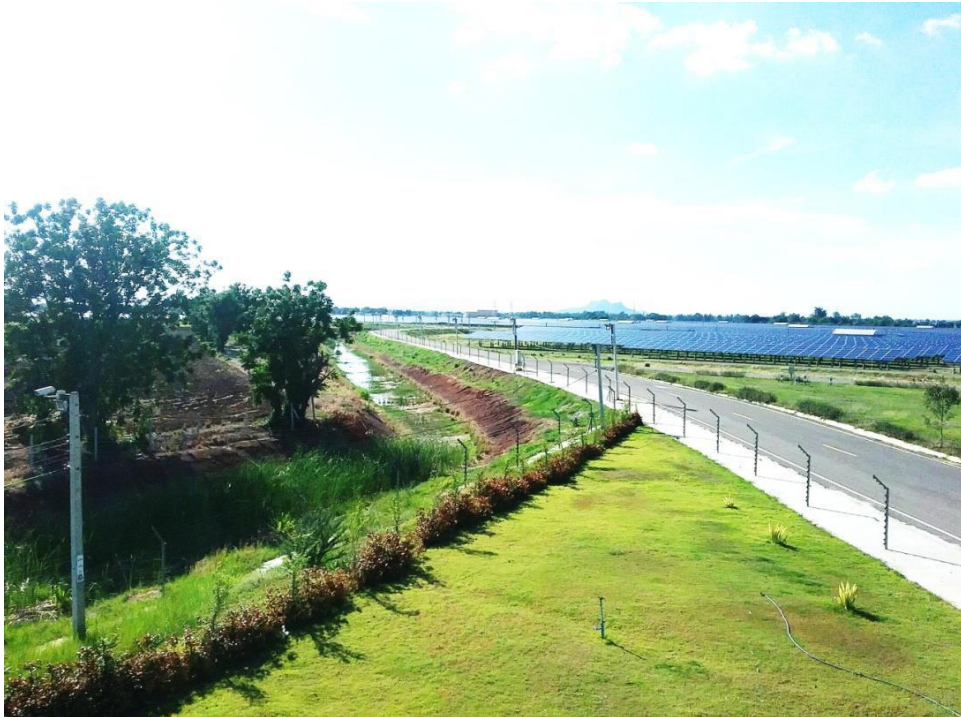
4. คลองรอบโรงไฟฟ้า ขนาด 144,000 ลบ.ม.
