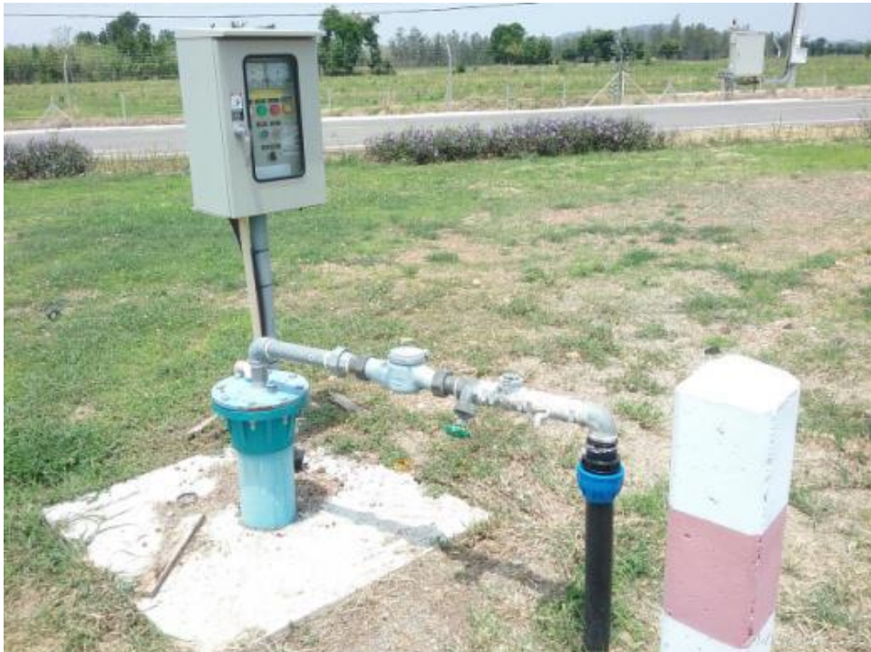
6. บ่อน้ำบาดาล บ่อที่ 2 ปริมาณน้ำที่สูบได้ 19 ลบ.ม./วัน
